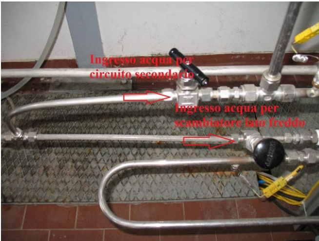
Figura 12-rubinetti per il reintegro e per lo scambiatore
