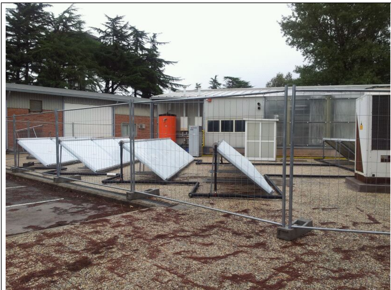
FIG. 7: CAMPO SOLARE IN FASE DI MONTAGGIO
