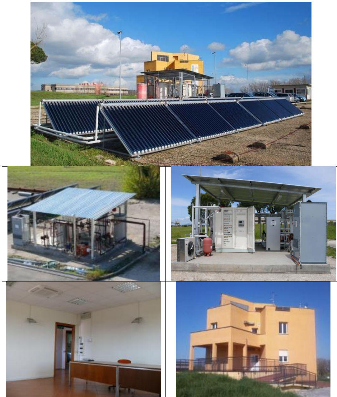
Figura 1: Viste dell'impianto e dell'edificio F-92
