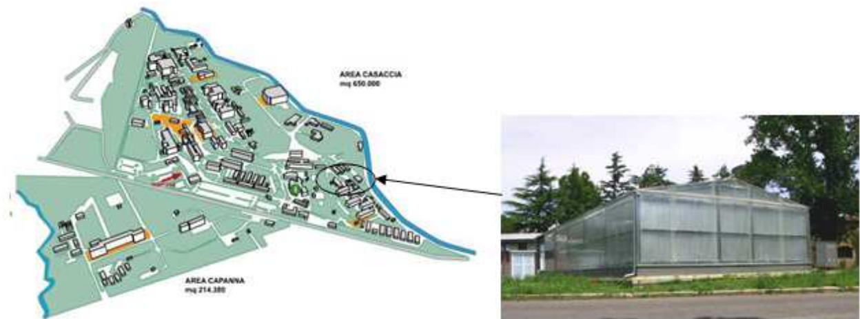
Figura 1 - Ed.F96 - Serra a contenimento
