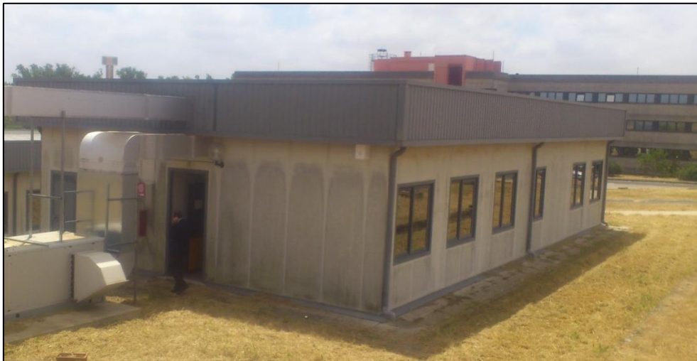
Figura 2.1.1 - L'edificio container F76. Sopralluogo Unisannio del 24 Giugno 2013
