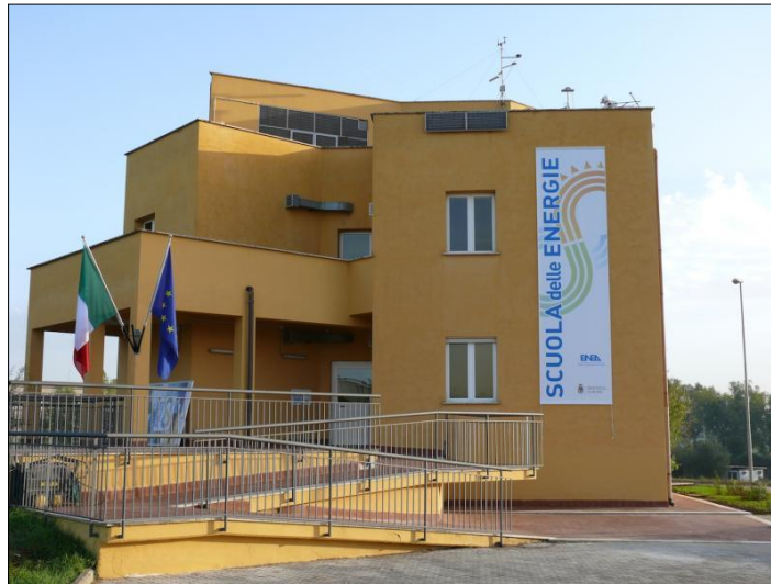
Figura 2.2.1 - Immagine reale dell'edificio oggetto di studio F92 di proprietà dell'ENEA
