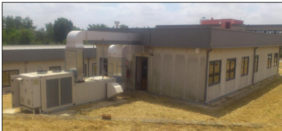
Figura 1.1.1 - Edificio e Rooftop di cui al Container F76
