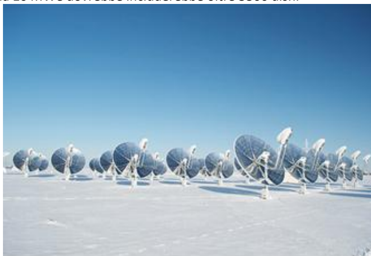
Figura 6. L’impianto da 1 MWe in Villarobledo vicino ad Albacete (E) a gennaio 2010. (Powerplay solar www.flickr.com )
