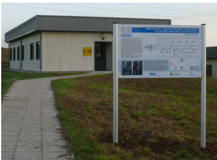
Figura 21 Edificio F76 presso l'Enea di Casaccia.
