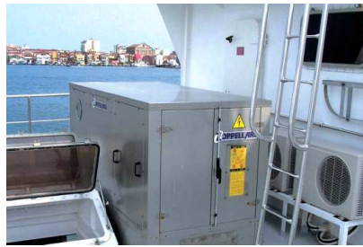
Figura 20 Roof top per le imbarcazioni.
