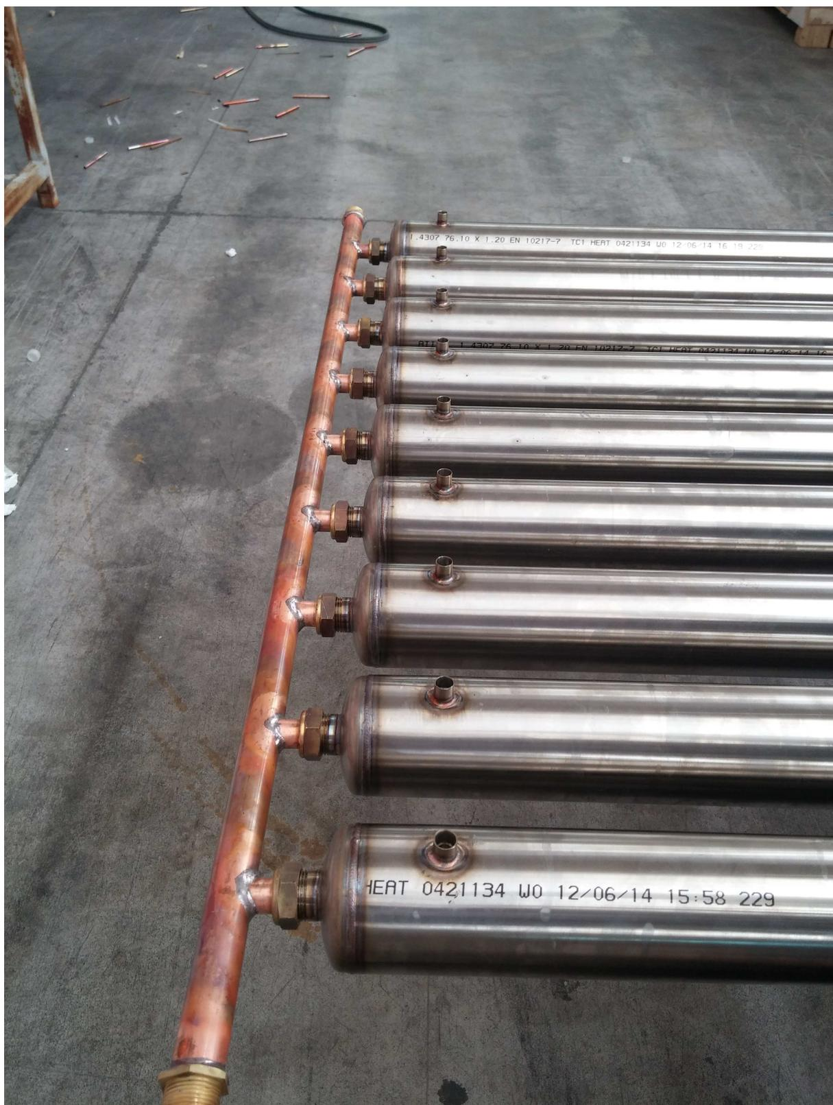
Fig. 24 – Particolare dell'attacco alla rete idrica.
