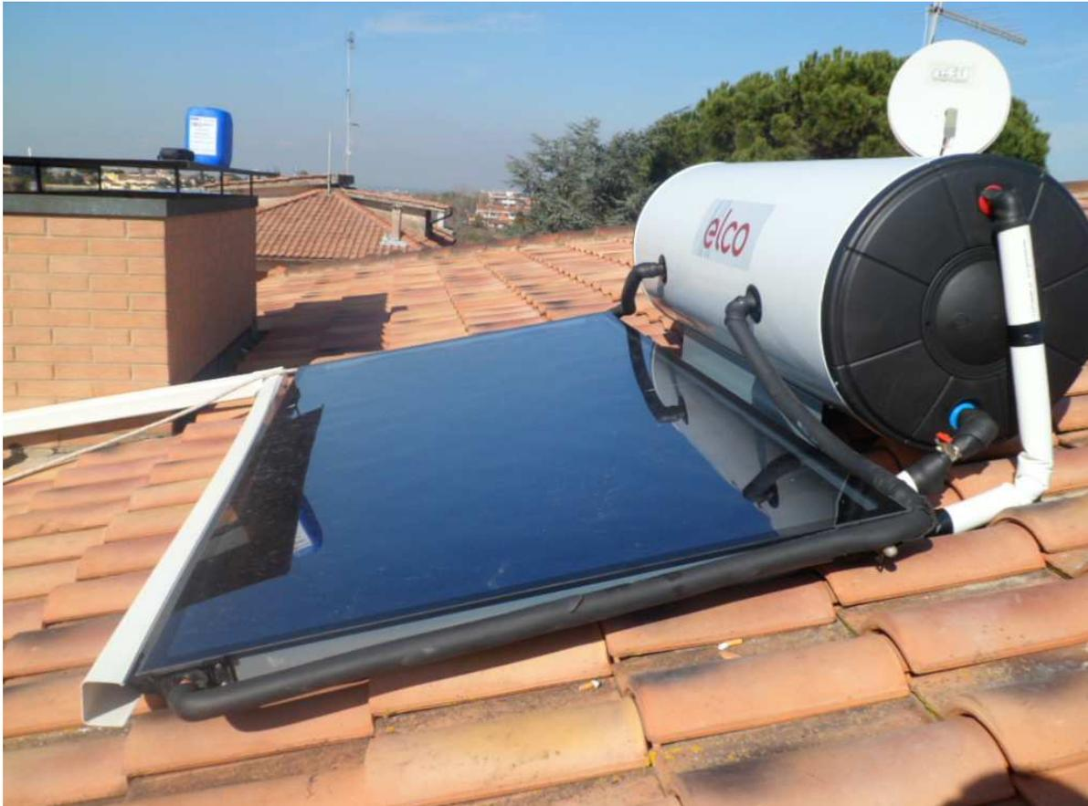
Fig.5 - Sistema solare a circolazione naturale per la produzione di acqua calda sanitaria con collettori solari piani idraulicamente connessi a un bollitore d'accumulo.
