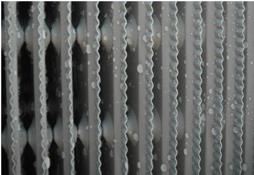
**Figura 46. Scambiatore di calore evaporativo a pacco**
