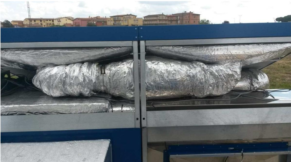
**Figura 9. Vista dei canali di collegamento dei collettori solari al ventilatore solare**
