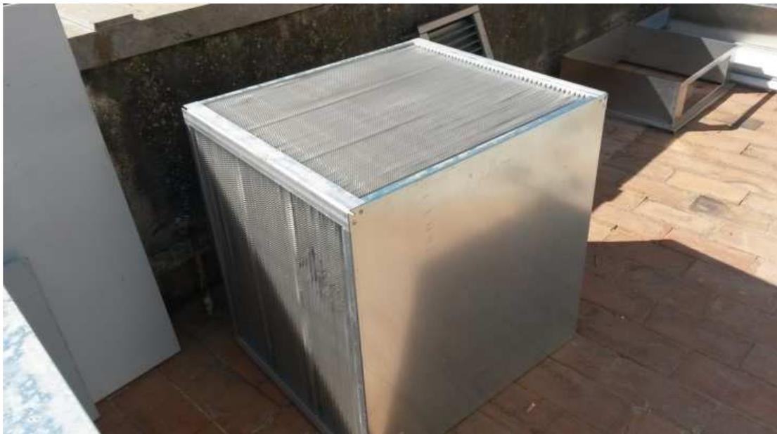
Figura 17b. Scambiatore di calore evaporativo a pacco
