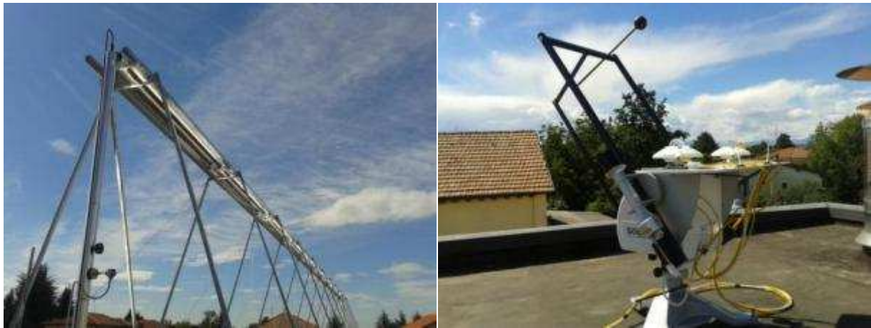
Figura 42: Foto di una installazione su cui sono state eseguite le sperimentazioni in campo e relativo dettaglio dell'apparecchiatura utilizzata per il monitoraggio della radiazione solare
