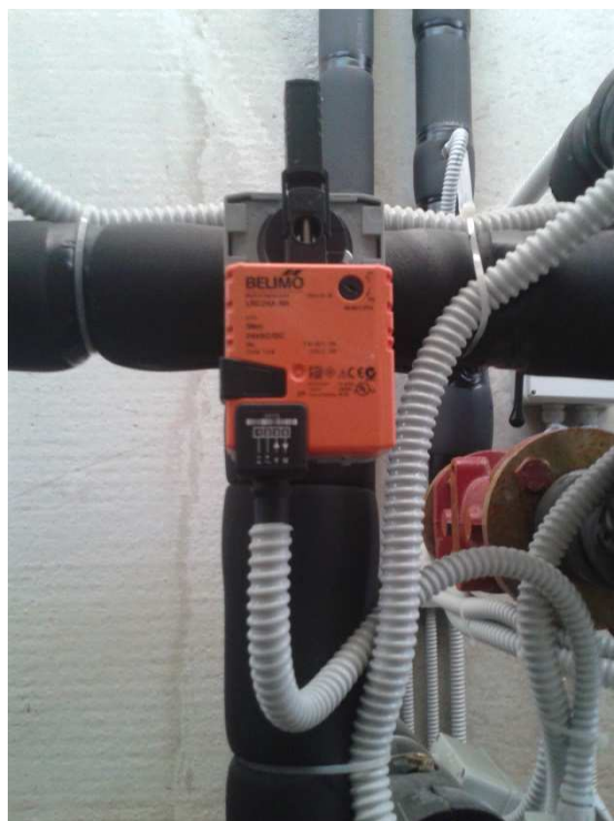
Figura 11. Valvola miscelatrice a tre vie
