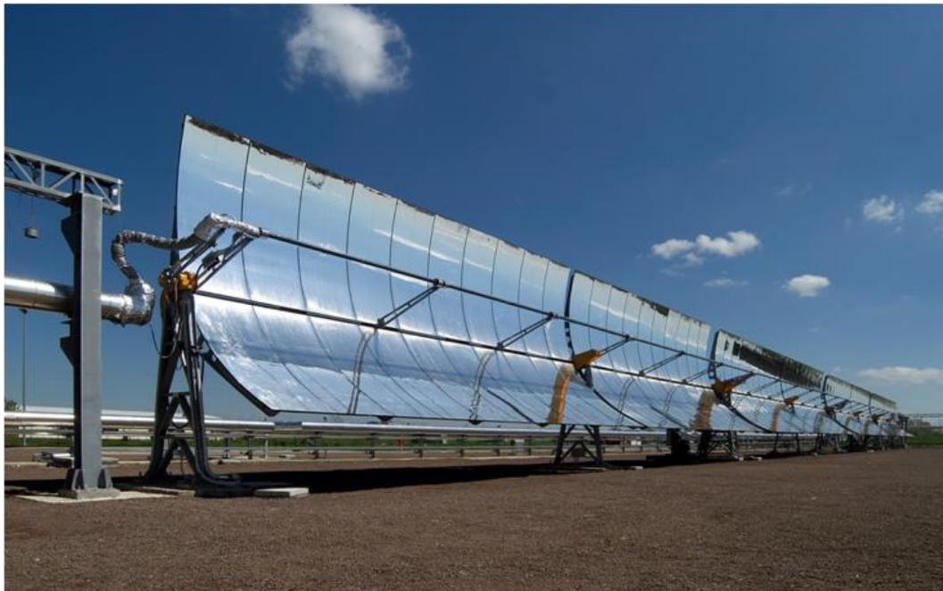
Figura 1 – Impianto solare termodinamico con collettori lineari parabolici (Archimede Solar Plants).
