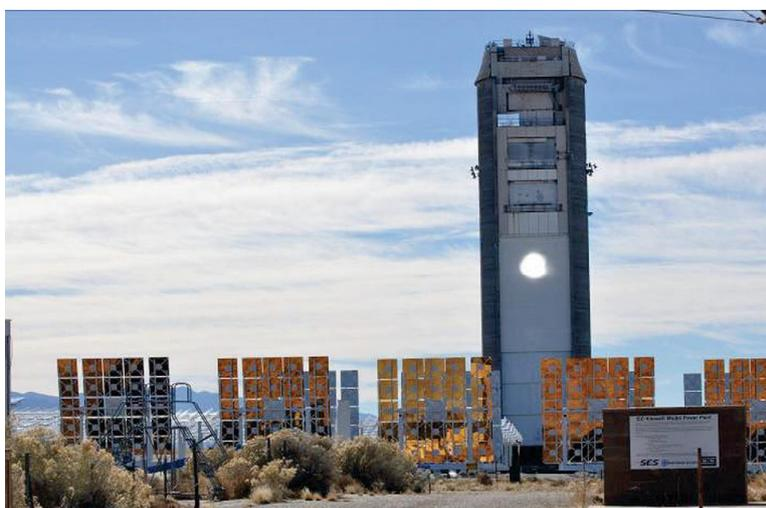
**Figura 25 – Metodo indiretto *PHLUX* applicato al ricevitore centrale posto sulla torre del campo di eliostati nei laboratori Sandia ad Albuquerque. (Ho e Khalsa 2012)**
