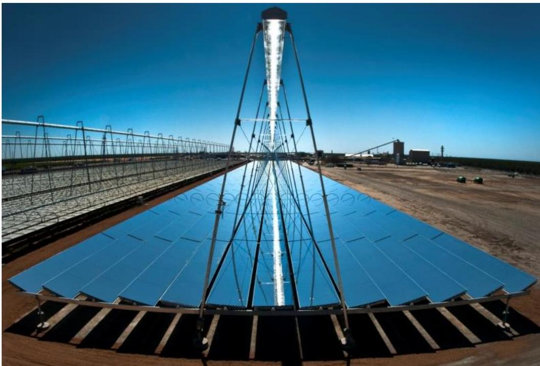
Figura 2 – Impianto solare termodinamico con collettori lineari Fresnel (Areva).
