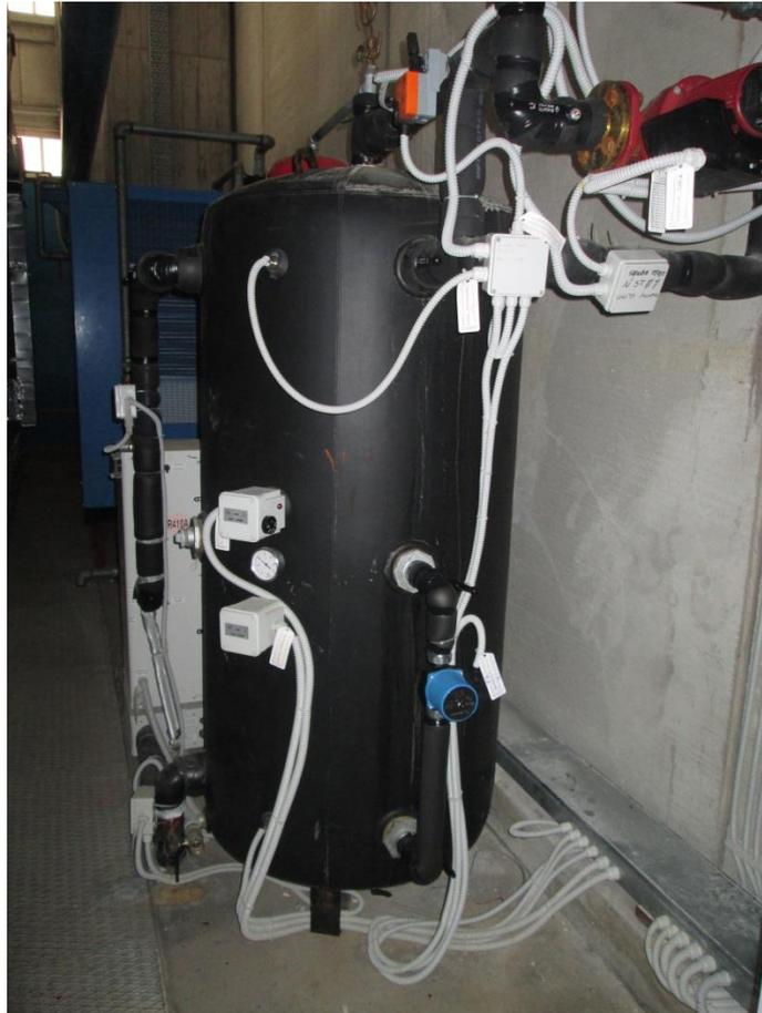
Figura 12. Serbatoio d'accumulo con resistenze elettriche e elettropompa di miscelazione
