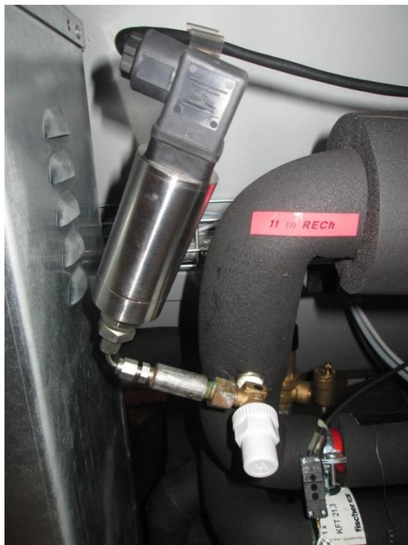
Figura 26. Misuratore di pressione GE Druck PTX montato sulla macchina in prova
