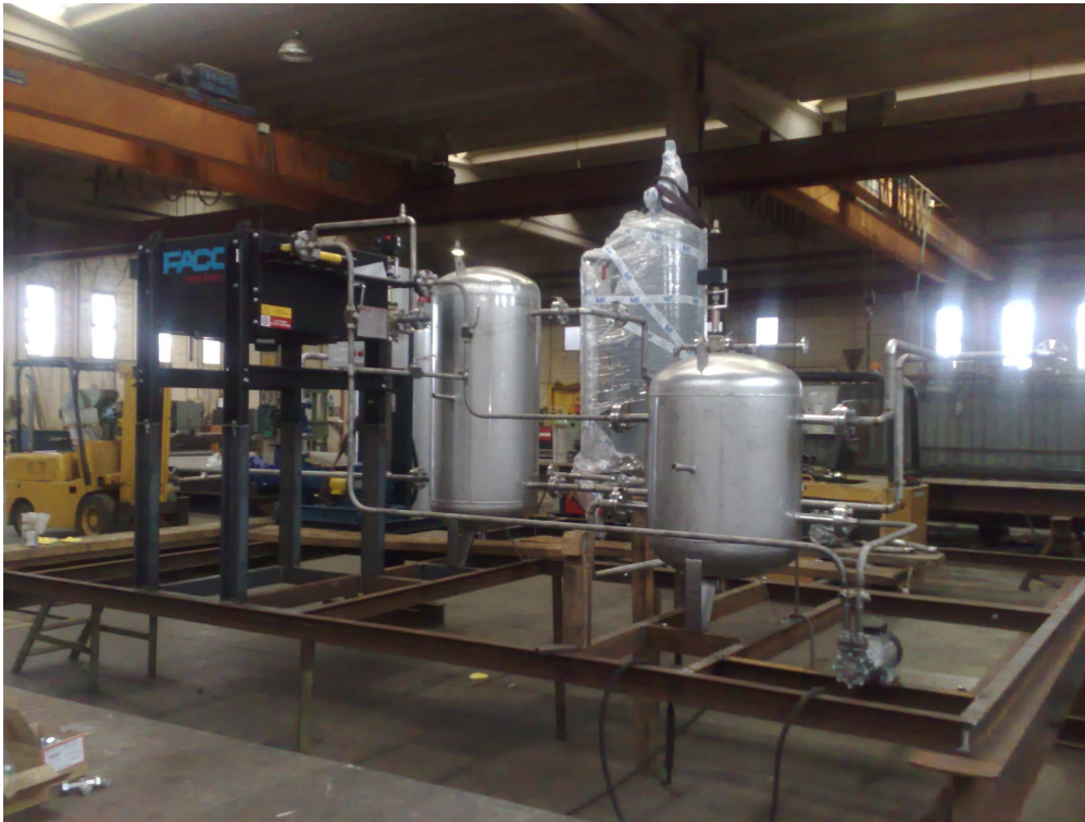
Fig. 17 – Foto durante la fase di assemblaggio
