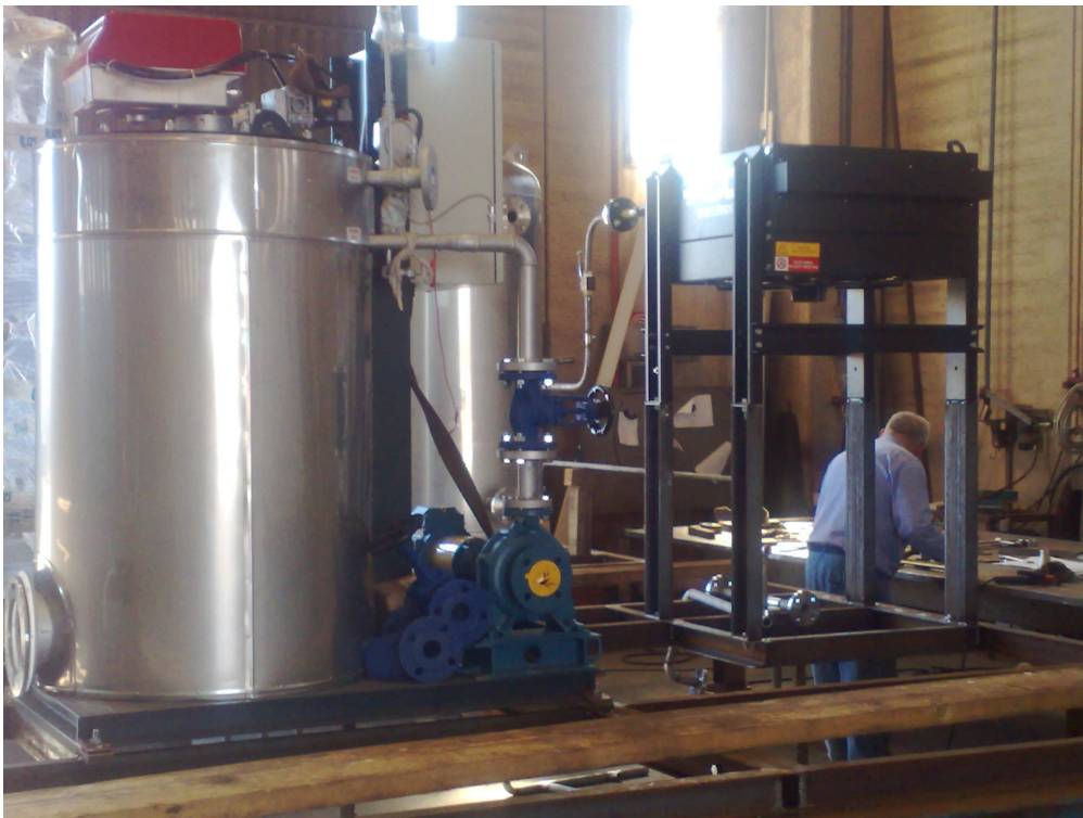
Fig. 16 – Foto durante le fasi di lavorazione
