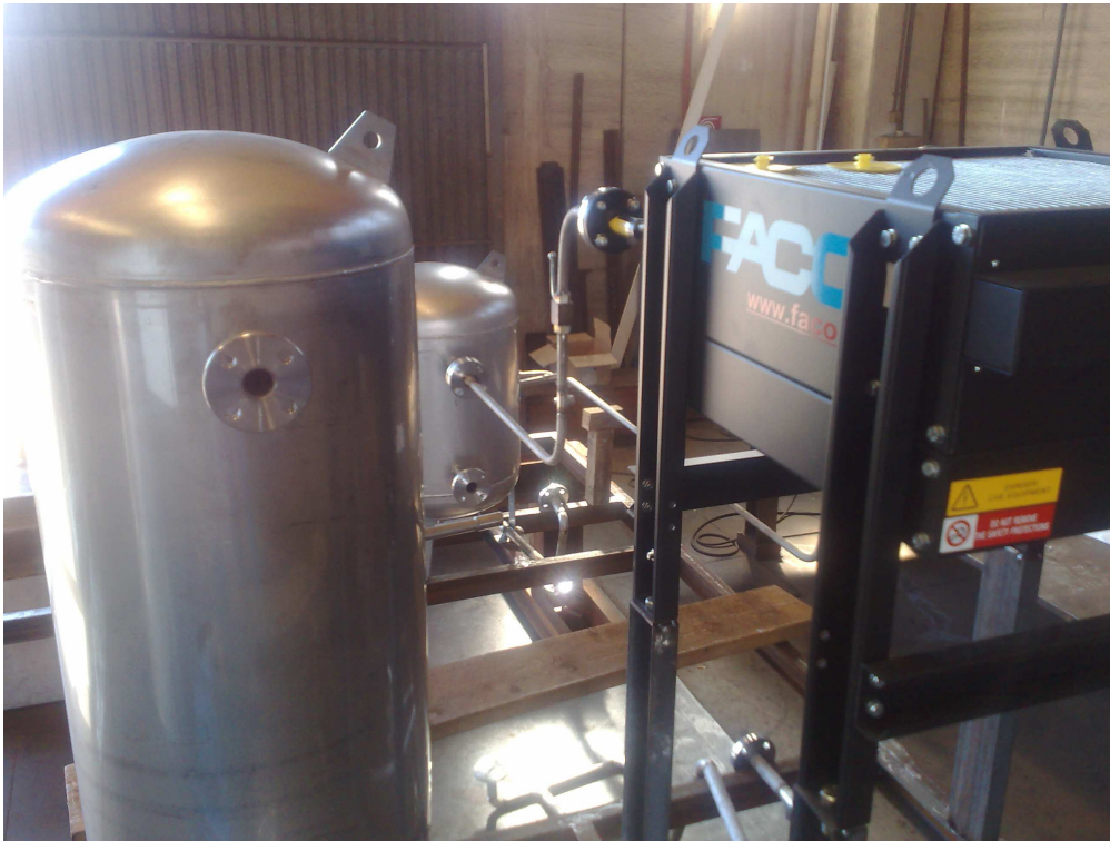
Fig. 15 – Foto durante le fasi di lavorazione
