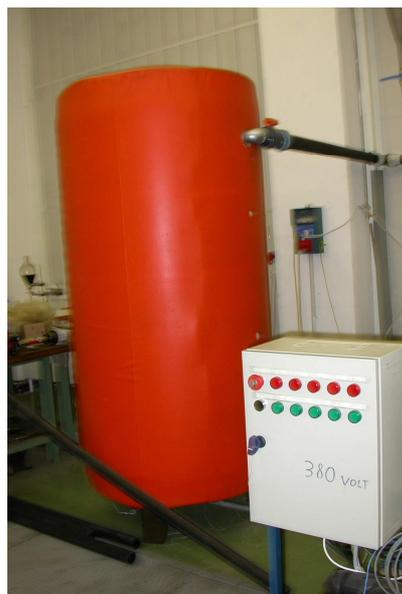
**Fig. 19 – Serbatoio inerziale in fase di montaggio**
