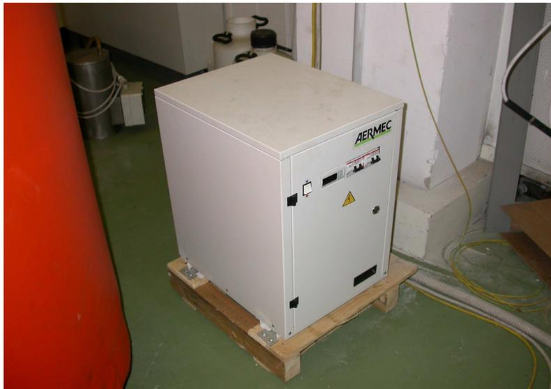
**Fig. 13 – Pompa di calore AERMEC 015H**
