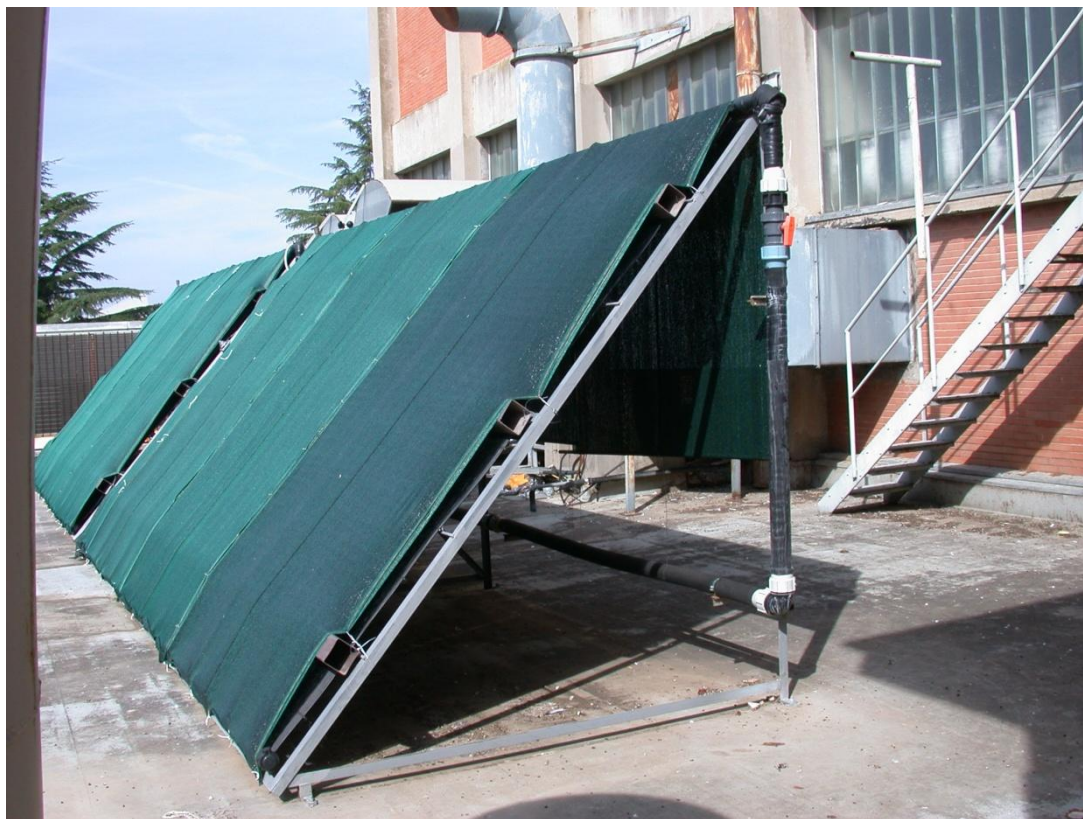
Figura 12; installazione dei teli ombreggianti sui pannelli.
