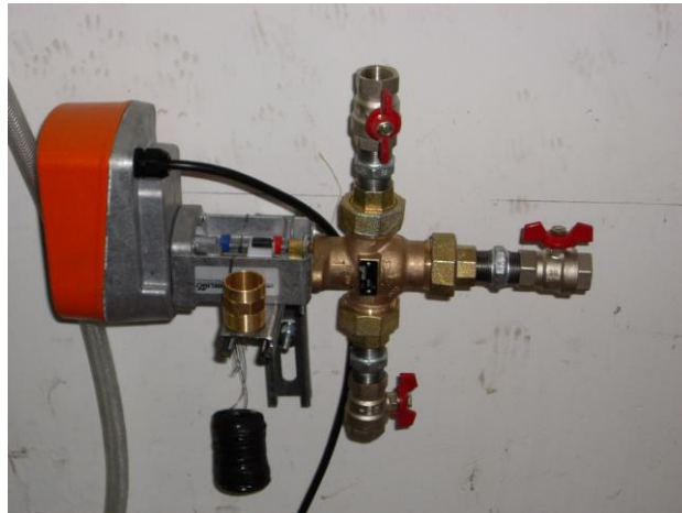
Fig. 17 - Valvola deviatrica e miscelatrice BELIMO
