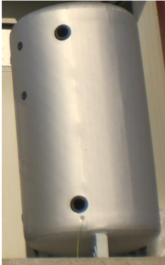
Fig. 20 – Serbatoio inerziale in fase di montaggio
