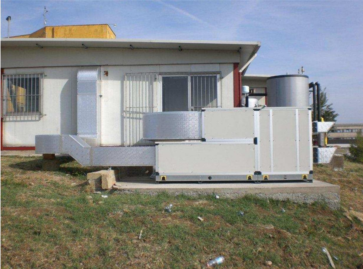
**Figura 17:** UTA LORAN: modalità di installazione
