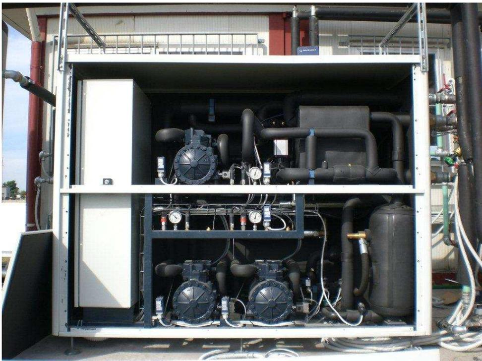
**Figura 15:** pompa di calore a CO<sub>2</sub> ENEX installata presso il Centro Ricerche della Casaccia
