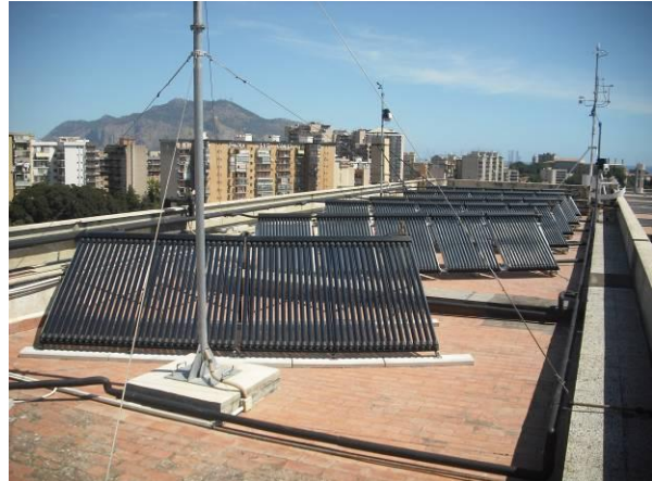
Figura 35: Foto dell'impianto realizzato e del campo di collettori solari a tubi evacuati
