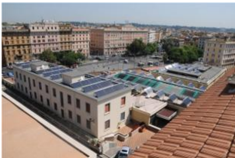
Figura 46 Campo solare dell'impianto di solar cooling in Città del Vaticano [34]
