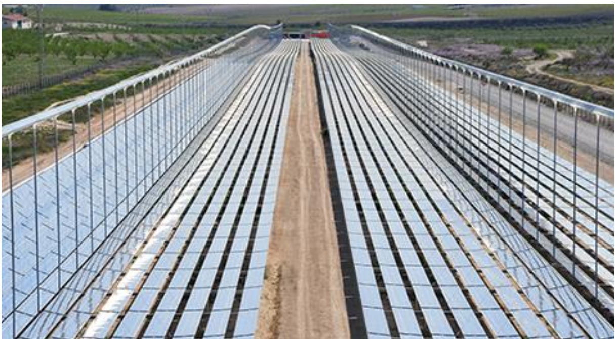
Figura 3.4 Rappresentazione schematica di un collettore lineare Fresnel.
