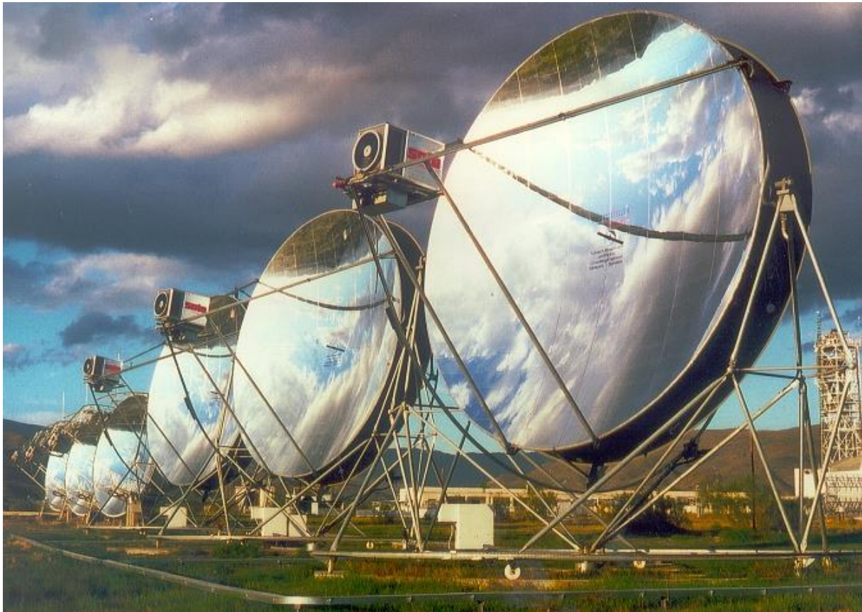
Figura 3.6 Rappresentazione di un collettore a concentrazione puntiforme.
