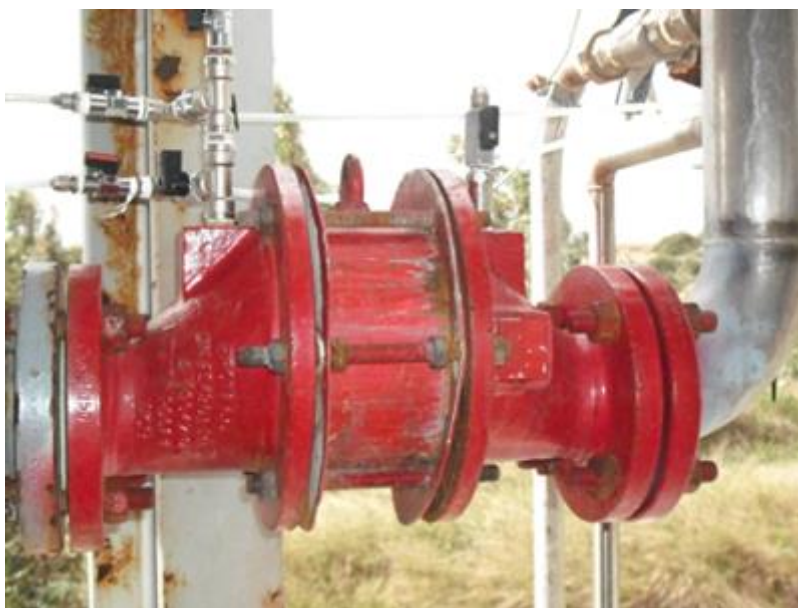
Figura 2.3 - valvola rompifiamma
