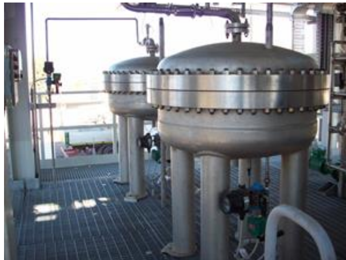
Figura 5-3 Reattori di assorbimento dell'anidride carbonica.
