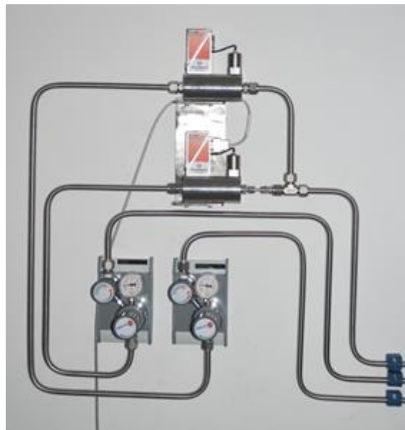
Figura 15-6 Riduttori di pressione di secondo stadio e regolatori di portata massica.
