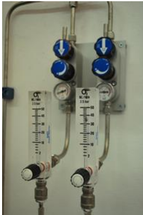
Figura 15-5. Sistema di regolazione finale della pressione e della portata della miscela gassosa.
