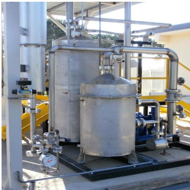
Figura 4 - Sistema di raffreddamento montato su skid.
