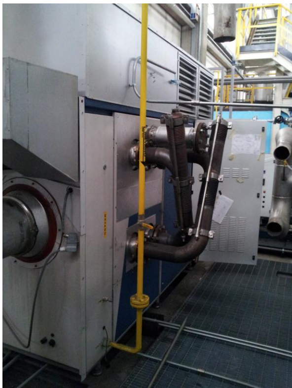
Figura 15. La microturbina svincolata dal vessel e resa operativa mediante il cross-piping.
