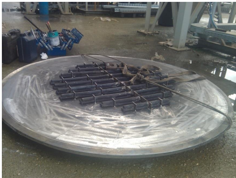
Figura 6 Revisione del piatto distributore del reattore SE-WGS
