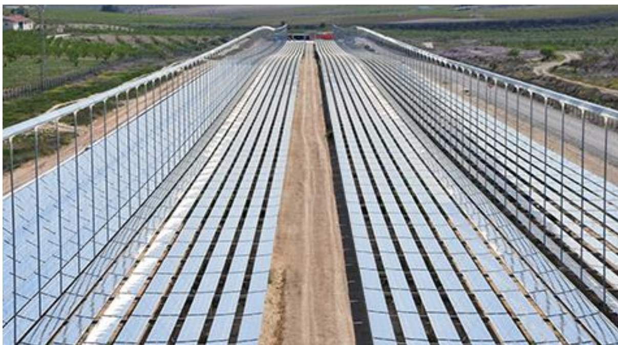
Figura 3.3 Rappresentazione schematica di un collettore lineare Fresnel.
