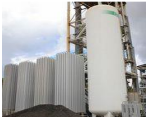
Figura 2.11. Sistema di stoccaggio e adduzione azoto liquido.
