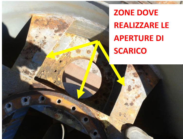
Fig. 2.4 – Vista di dettaglio della struttura di sostegno della griglia e del pignone
