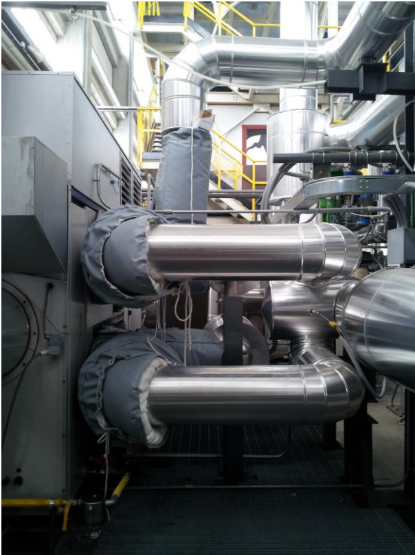
Figura 6. Tratto binato di piping in cui coesistono le coperture semirigide rimovibili e i materassini per i tratti in cui ingombri e/o geometrie sono particolarmente problematici.
