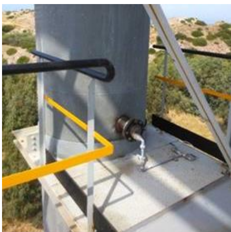
Figura 18, 19. Presa di campionamento DJ003 (torcia)
