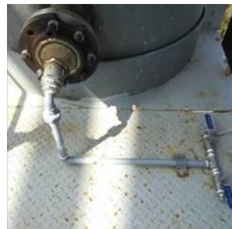
Figura 18, 19. Presa di campionamento DJ003 (torcia)
