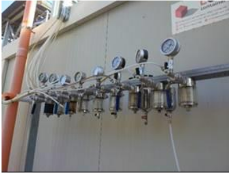
Figura 14, 15. Rastrelliere di raccordo per le linee di campionamento per sistema di analisi ABB (a sinistra) e per gascromatografo portatile (a destra)
