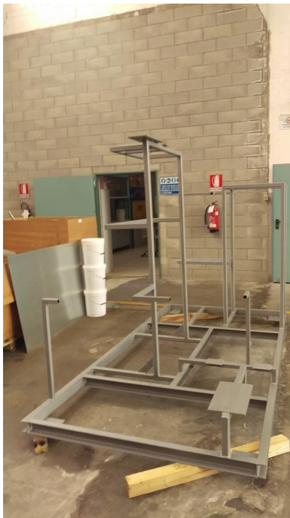
Figura 6-1 Strutture metalliche dello skid
