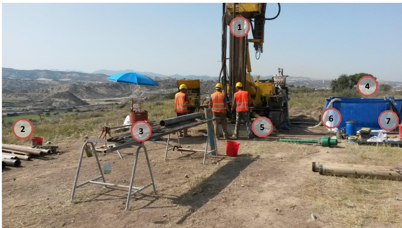
Figura 34: Area di cantiere per le perforazioni profonde
