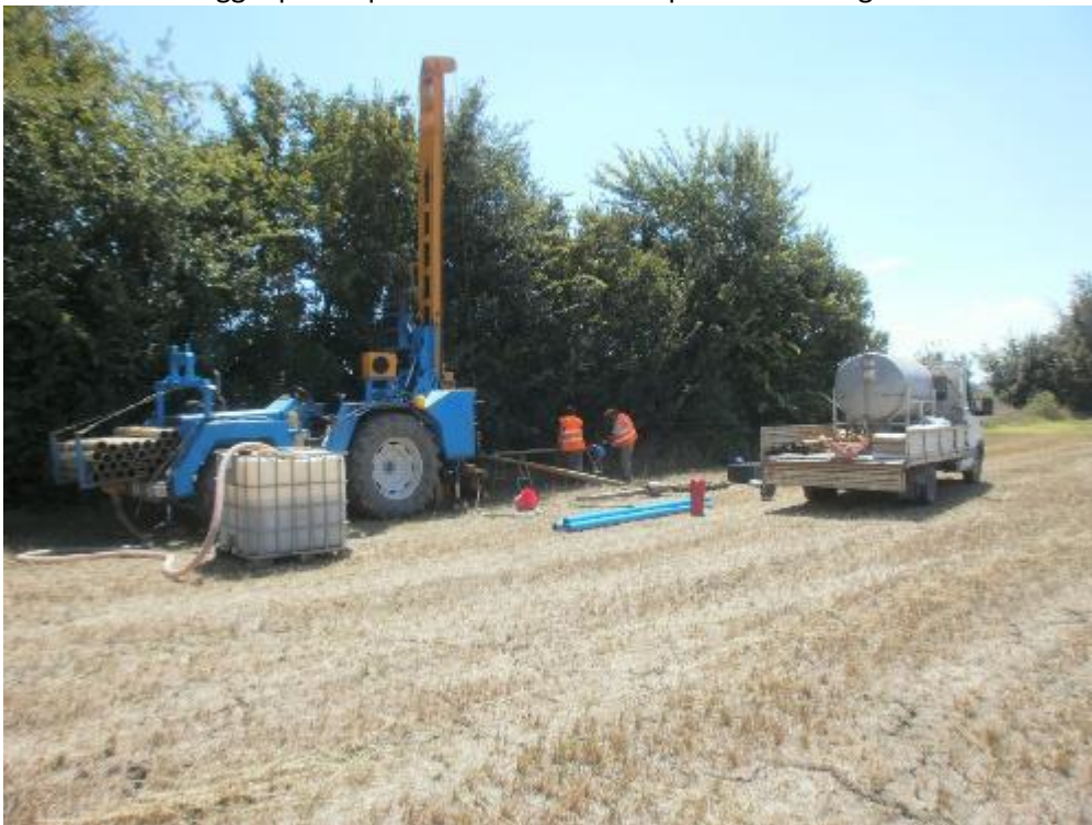
Figura 30: Area di cantiere perforazioni superficiali
