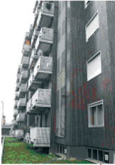
Edificio A - Lato est
