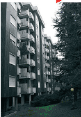
Edificio A - Lato ovest
