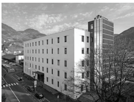
Fig.1: Vista dell'edificio dopo l'intervento.
