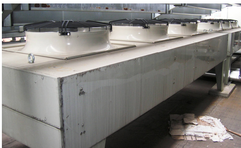
Figura 4. Condensatore remoto del gruppo frigorigeno
