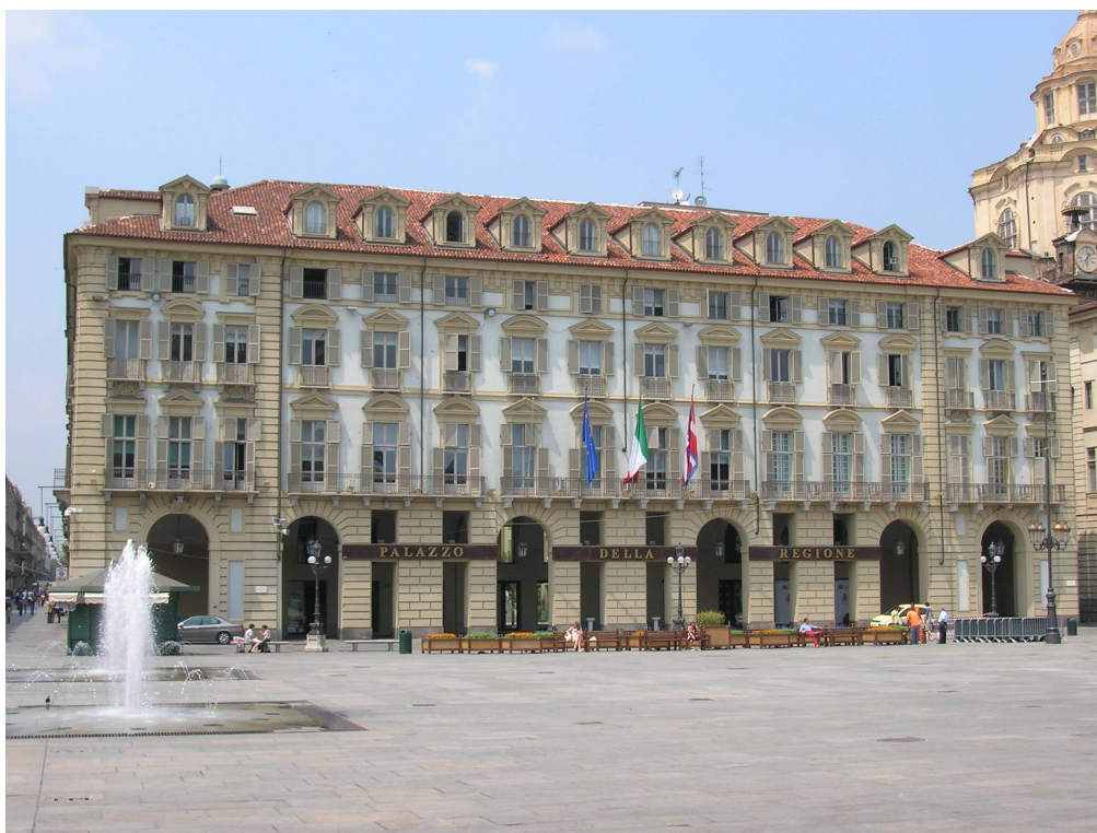
Figura 1. Vista del palazzo della Regione lato piazza Castello
