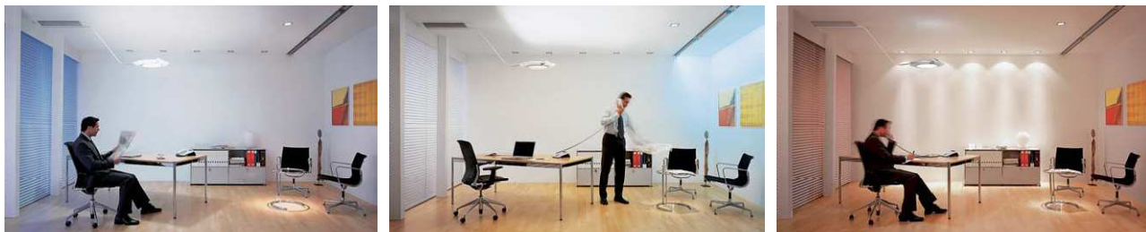
Figura 3 - Esempio di sistema di controllo in grado di impostare e richiamare diverse scene di luce in relazione alle attività e ai momenti della giornata (fonte: ZUMTOBEL)
