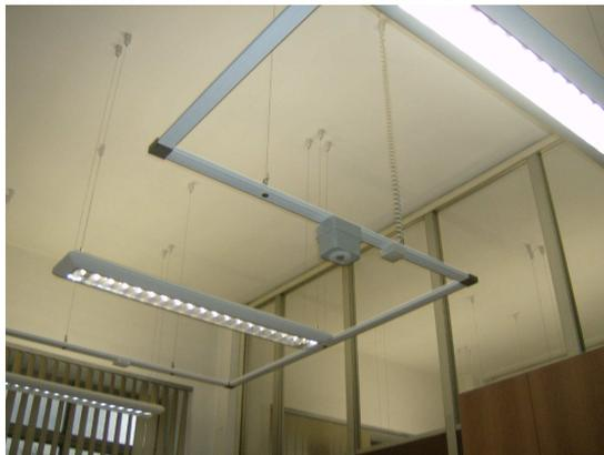
Per quanto riguarda il controllo della luce artificiale il sistema presenta un numero totale di 19 dispositivi e tre centraline di controllo LON/DALI.
