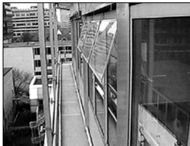
Figura 1.31. Vista esterna di una test room con pannelli laser cut ruotati nel terzo superiore della vetrata.
