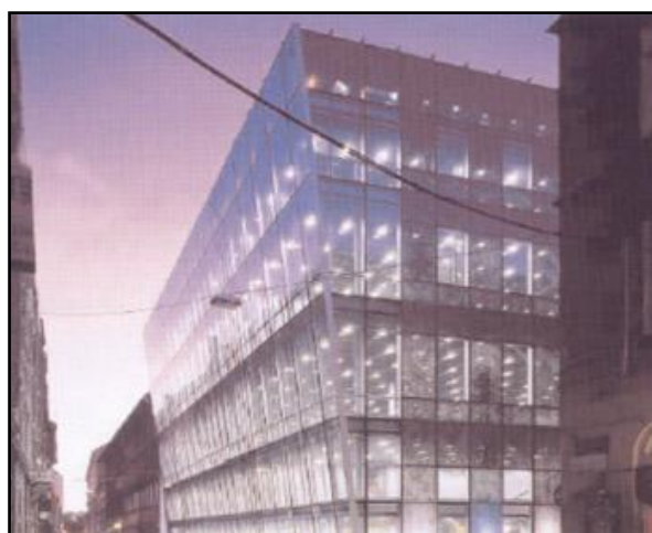
Figura 1.79. Ricostruzione di facciata con impiego di vetri fotocromici
