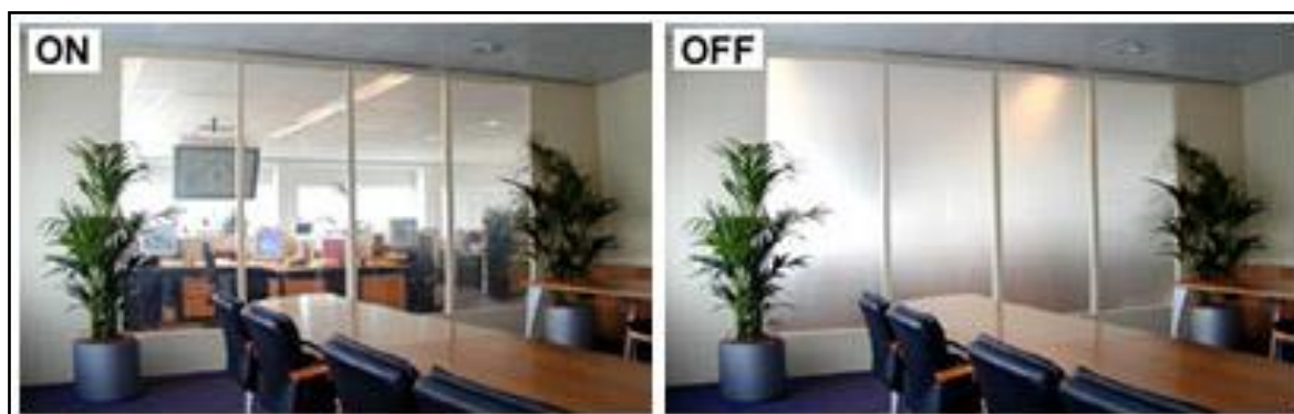
Figura 1.86. Sala riunioni dotata di parete di vetro a cristalli liquidi.
