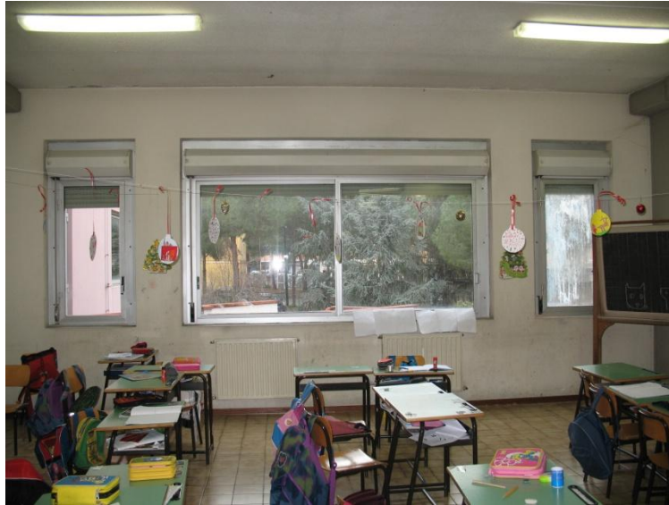
Figura 5.5. Aula: zona finestra
