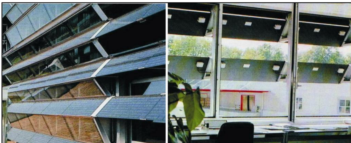
Figura 1.16. Sistema a lamelle con fotovoltaico integrato: lato esterno (sinistra) e lato interno (destra)
