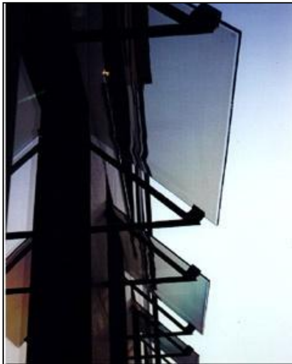
Figura 1.48. Uffici ADO, Colonia, Germania. Particolare della facciata esterna.
