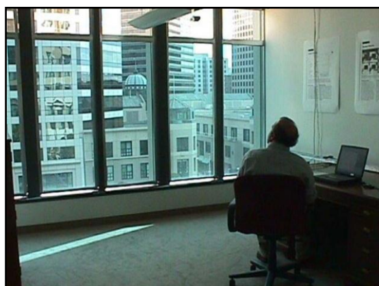
Figura 1.81. Finestra con vetri elettrocromici, in basso nella forma colorata, in alto in quella trasparente.
