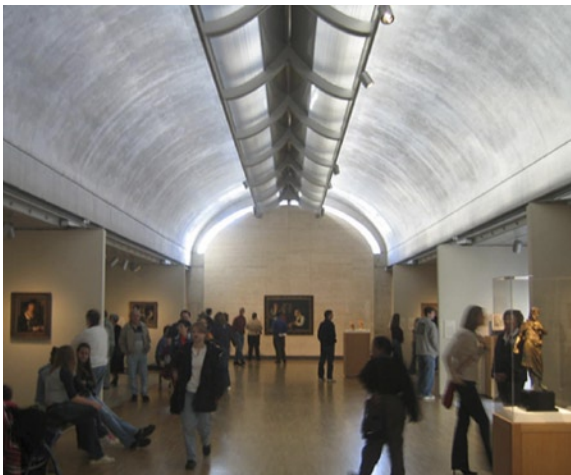
Fig. 117 - Kimbell Museum of Art, Fort Worth, Texas. Il progetto di Louis Kahn si compone di una serie di tunnel affiancati, coperti da volte cicloidal che integrano un dispositivo capace di schermare la luce diretta e rinviarla verso la superficie delle volte che diventano così dei grandi diffusori.
