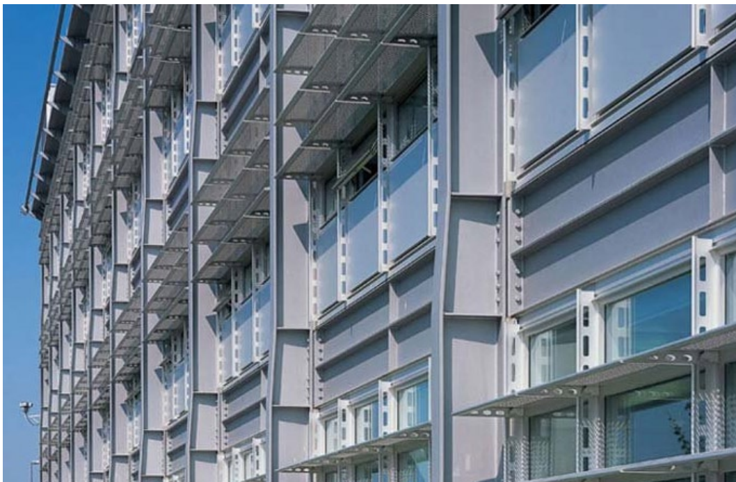
Fig. 13 - Edificio per gli uffici di DSS a Newcastle, di Hopkins Architects. L'architettura è modellata per abbattere i consumi energetici attraverso la ventilazione naturale e l'utilizzo razionale della luce diurna.
