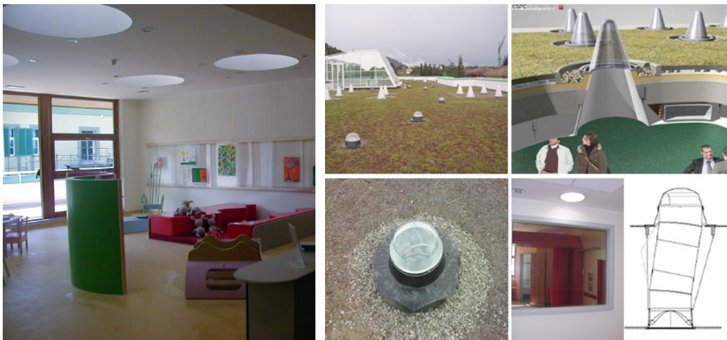
Fig. 109 - Ospedale Meyer a Firenze. Camini solari conici e condotti di luce apportano luce naturale anche nelle zone più interne dell'edificio.
