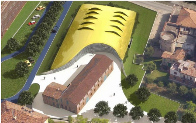
Fig. 125 - Progetto del Museo Maserati a Modena dello Studio Future Systems. L'ingresso della luce naturale nel grande ambiente interno è assicurato dalle feritoie orientate a nord inserite nella copertura. Sarà un complesso museale ad alto risparmio energetico ed elevata sostenibilità ambientale, poiché dotato di sistemi di controllo e dispositivi geotermici e realizzato con materiali e soluzioni impiantistiche all'avanguardia.
