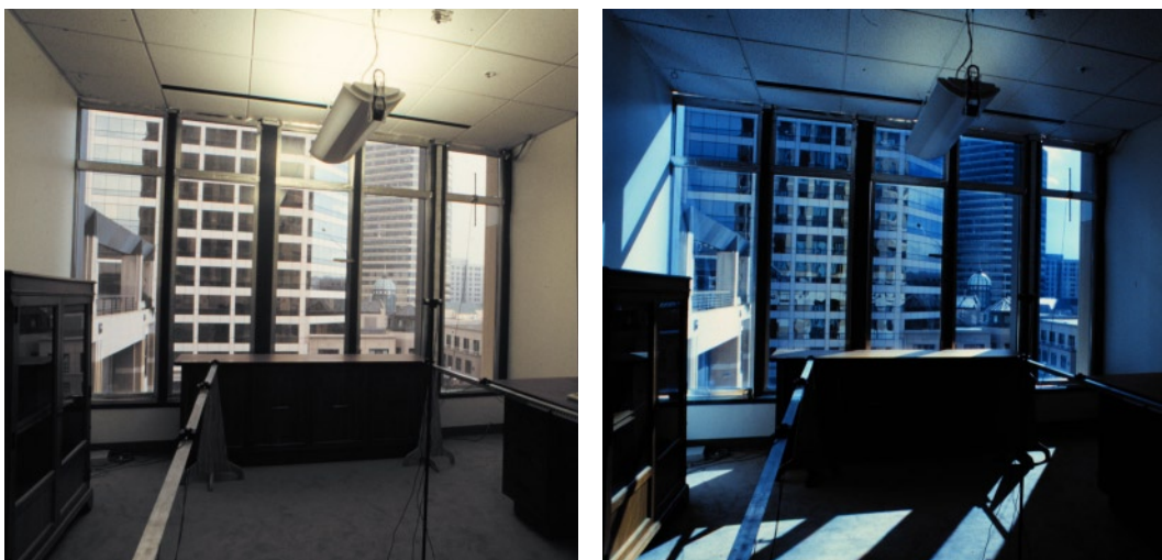
Fig. 28 - Esempio di vetro elettrocromico in stato disattivato (trasparente) e in stato attivato (colorato in blu).
