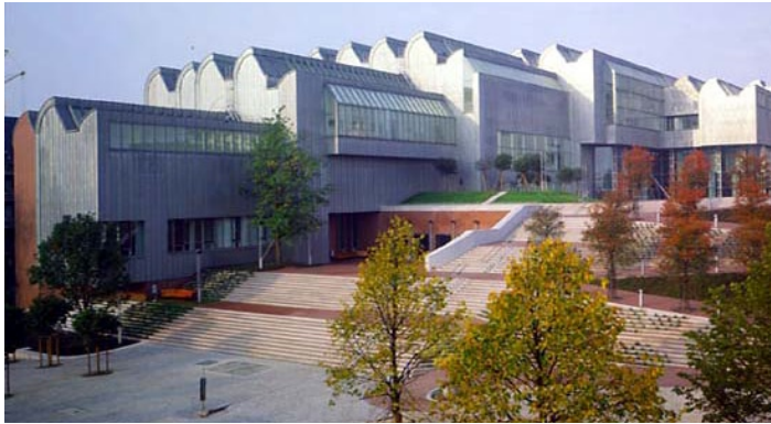
Fig. 119 - Ludwig Museum a Colonia. La luce diurna è filtrata da decine di shed inclinati che inviano la luce verso superfici curve dalle quali viene riflessa nell'ambiente in maniera morbida e naturale (prog. Busmann e Haberer).
