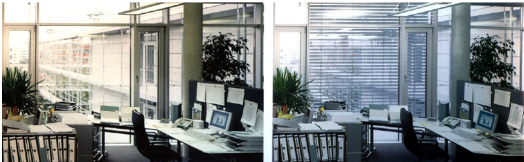
Fig. 82 - Il sistema di controllo della luce, oltre a spegnere gli apparecchi in caso di sufficiente illuminamento naturale, può provvedere alla schermatura delle finestre per migliorare il comfort degli utenti (immagine Zumtobel).
