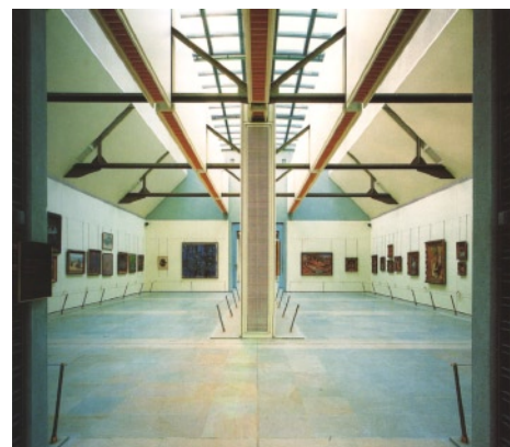
Fig. 118 - Musée d'Orsay, Parigi. Il progetto di Gae Aulenti nasce in funzione del controllo della luce naturale. La luce artificiale è integrata agli stessi sistemi che convogliano la luce diurna (progetto illuminotecnico Piero Castiglioni).
