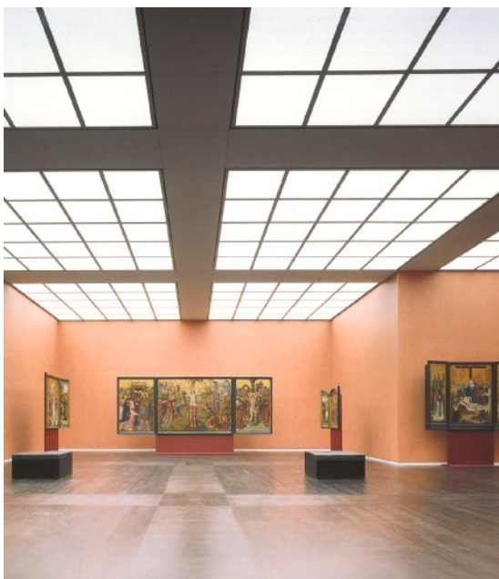
Fig. 116 - Wallraf-Richartz Museum a Colonia. Nel progetto di Ungers la luce naturale è completamente assente e viene solo simulata da ampi soffitti luminosi dotati di sorgenti luminose controllate con sistemi di gestione.
