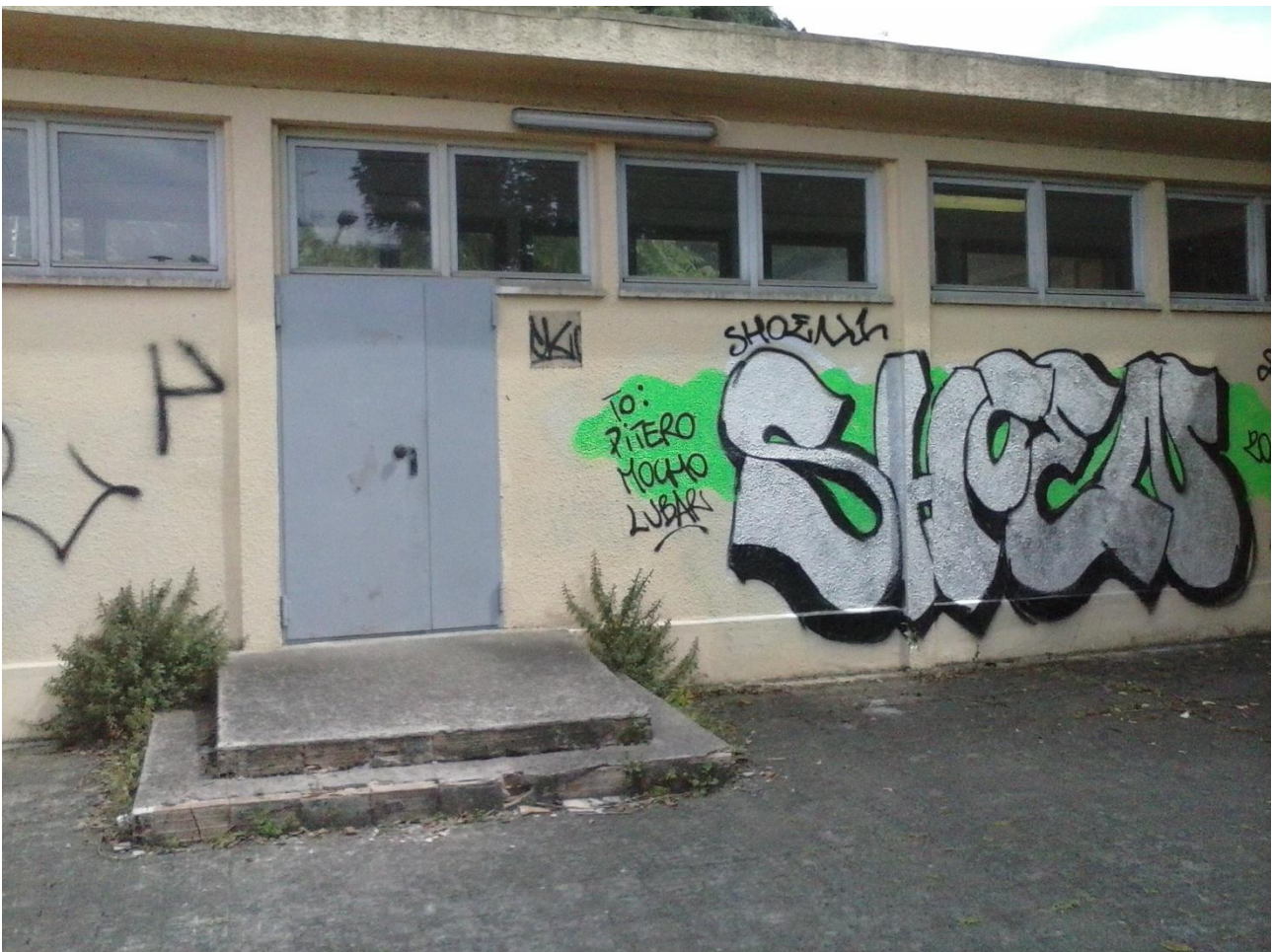
Foto 13. Prospetto su via Venezuela
