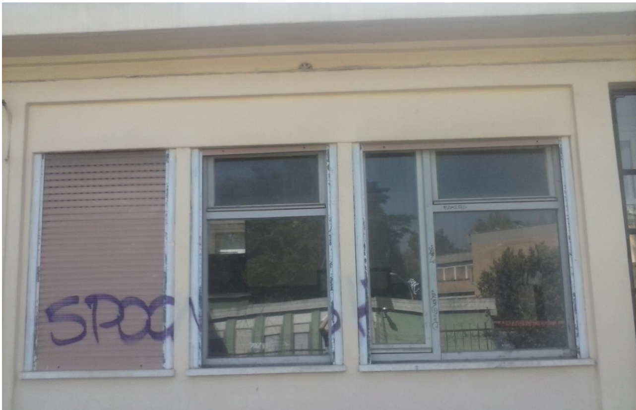
Foto 6. Esterno finestre aule - laboratorio
