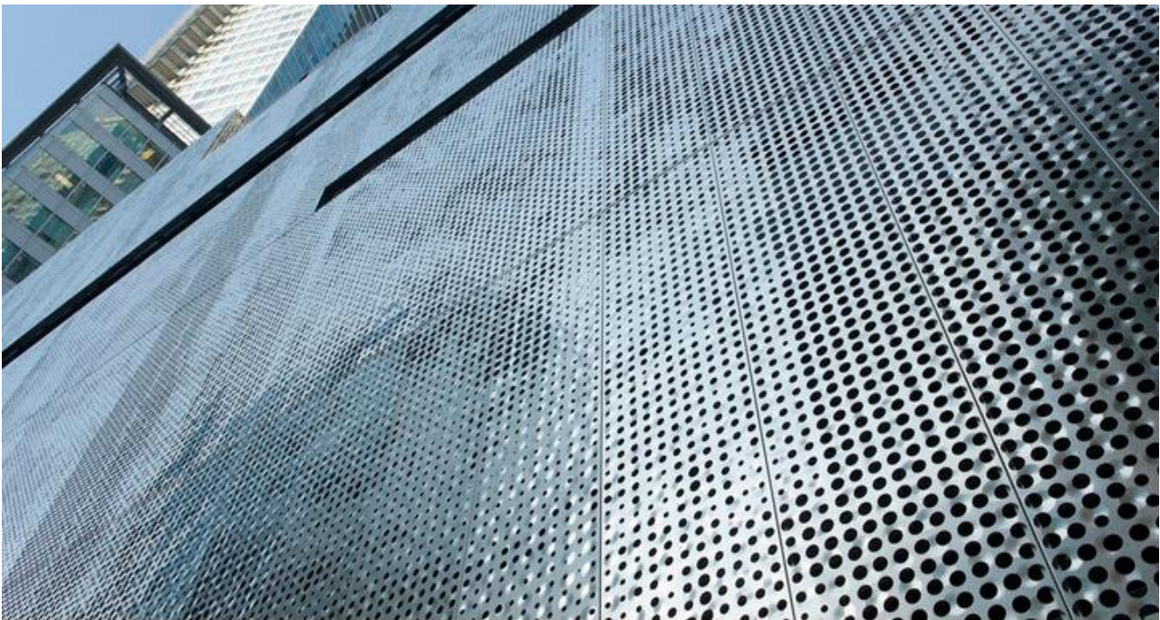
Fig. 4 – Seconda pelle come sistema di controllo solare costituita da lamiera microforata riflettente con fori a geometria variabile. FAIRMONT PACIFIC RIM (fonte: http://www.archiexpo.com )
