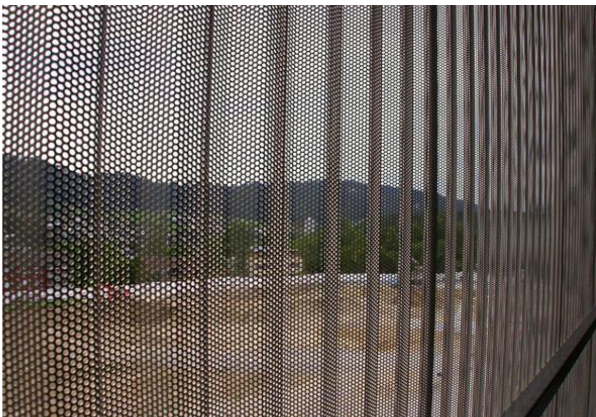
Fig. 5 – Seconda pelle come sistema di controllo solare costituita da lamiera microforata a geometria variabile. MZH Reiden (fonte: http://www.schaefer-lochbleche.de )
