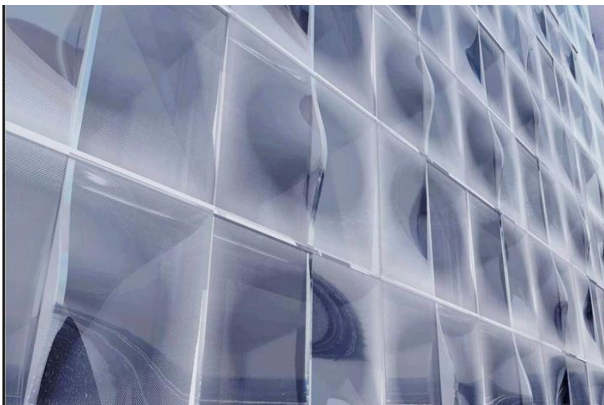
Fig. 6 – La pelle dell'edificio è costituita da elementi lastre in vetro con differenti curvature e gradi di opalescenza (fonte: http://xsdri.wordpress.com/2011/02/05/glass-leaves/ )
