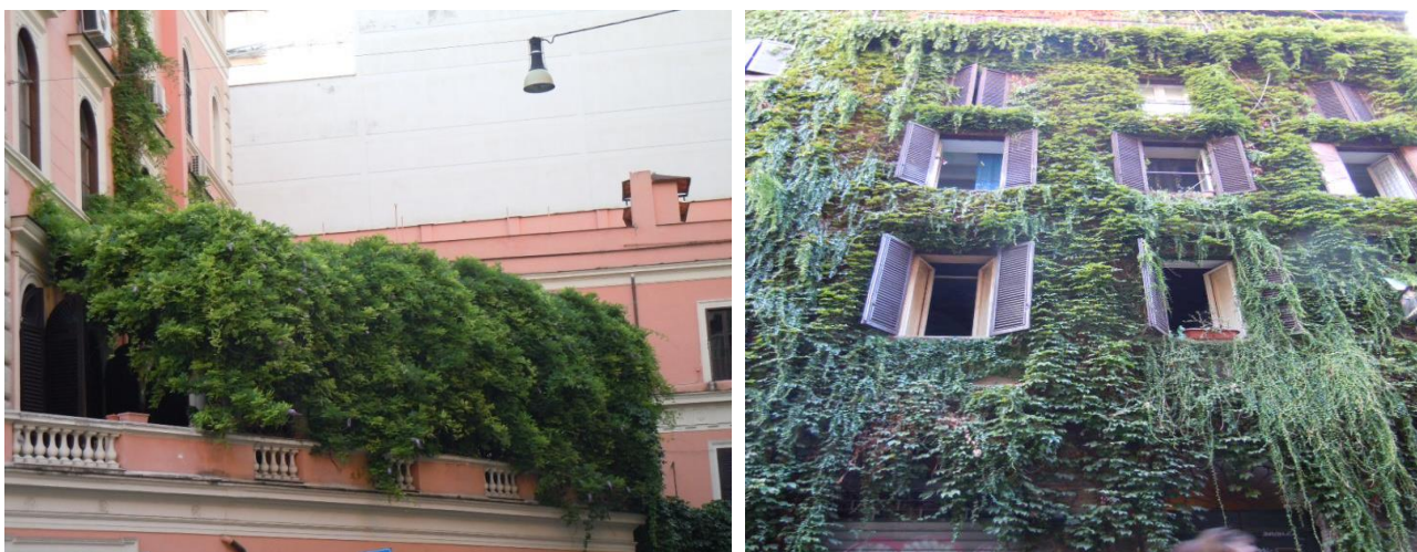
Coperture su terrazzo esterno e a parete
