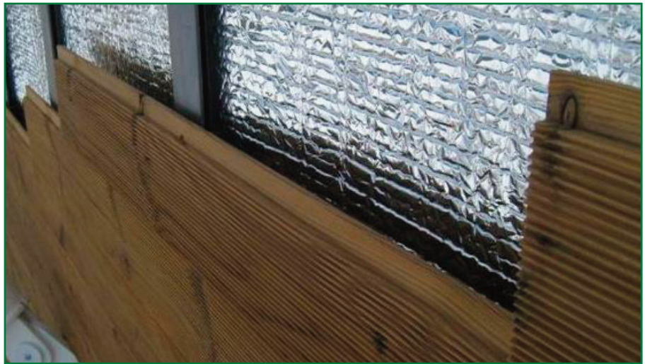
Esempio di cappotto esterno riflettente (S.A.M.E.): strato esterno in ossido di magnesio; Isoliving in doppio strato; montanti a pettine in ABS (studiati in modo tale da assicurare la posa corretta dell'isolante riflettente)
