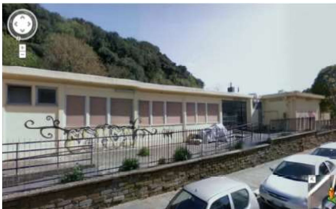
Figura 2. Vista prospettica su via Venezuela. (Fonte: Google Maps)
