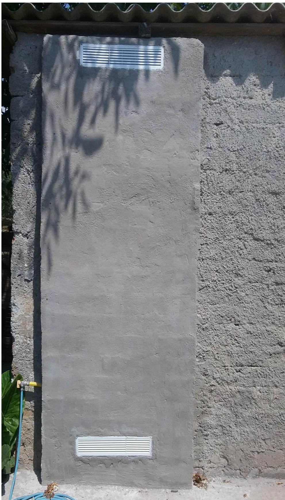
Figura 4. Inserimento della tubazione gas nella parte bassa della parete
