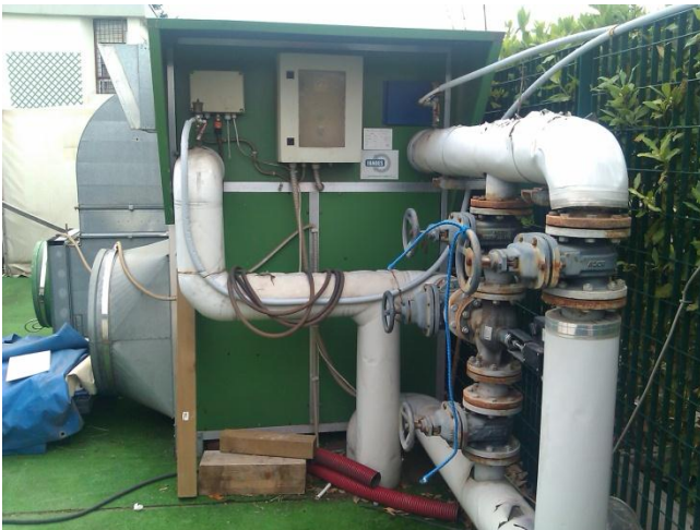
Fig. 25 – Termoventilante Piscina.
