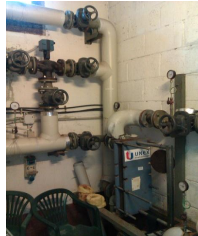
Fig. 26 – Scambiatore Acqua/Acqua.
