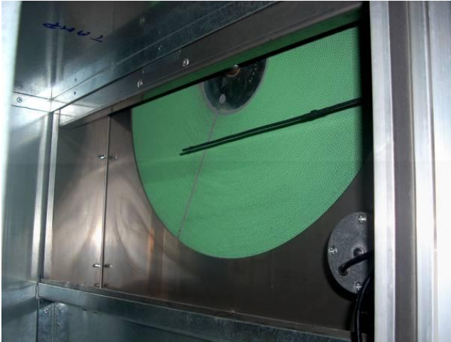
Figura 3. Il settore di adsorbimento della ruota
