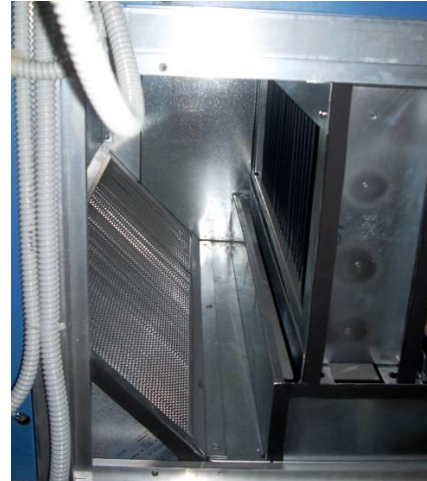
Figura 4. Scambiatore a flussi incrociati
