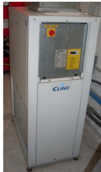
Figura 10. Chiller elettrico
