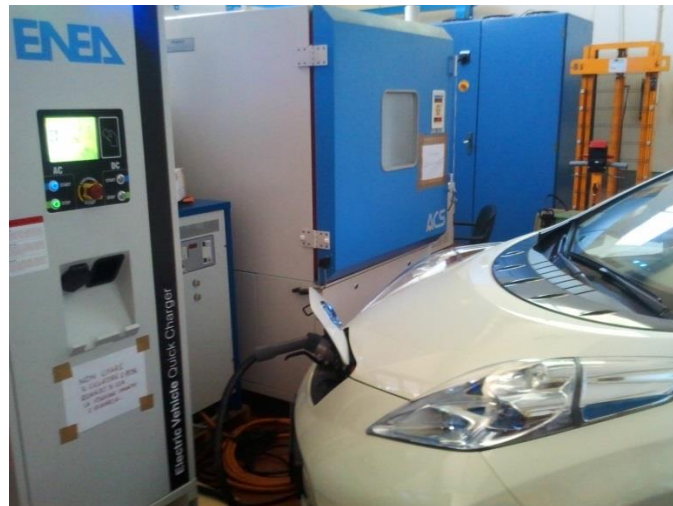
Figura 12 Collegamento alla stazione di ricarica del veicolo tramite connettore CHAdeMO
