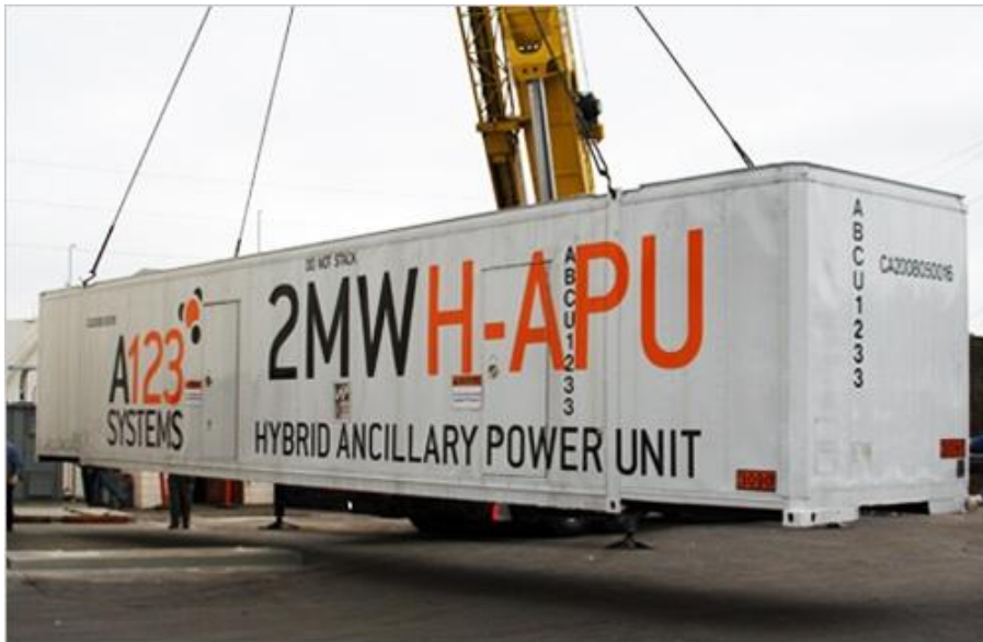
Figura 7. Modulo di alta potenza da 2 MW di batteria agli ioni di litio della A123.
