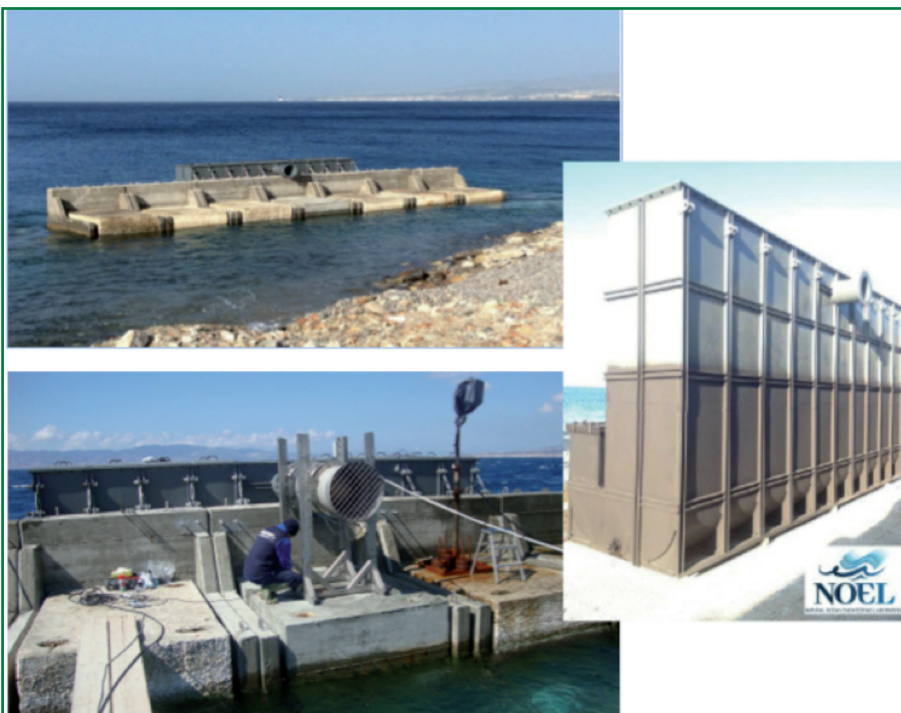
Diga e cassone metallico REWEC3, con installata turbina di tipo Wells, esistente presso il NOEL
